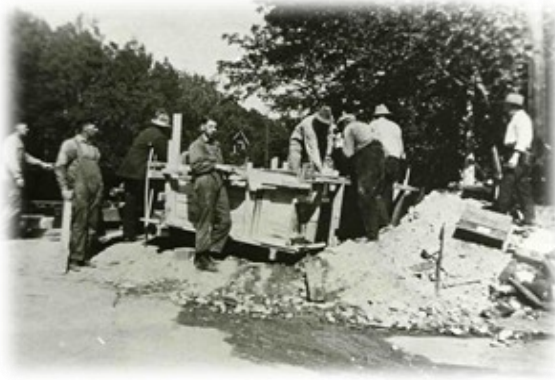
Gjutningsarbete vid brobygget 1928.
