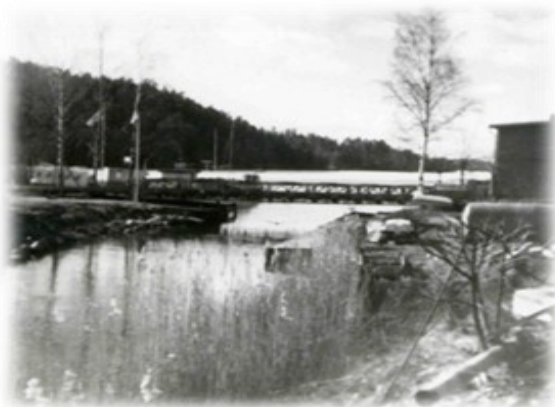
Vy över den provisoriskt anlagda militär- bron 1972 när Strömma kanals bro (klaffbron) reparerades.
