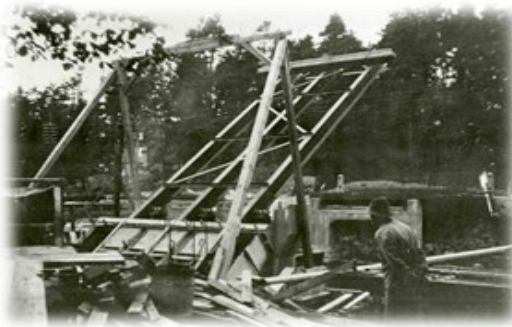
Bygge av bro över Strömma kanal år 1928, klaffkonstruktion uppfälld. Bilden tagen från södra brofästet.
